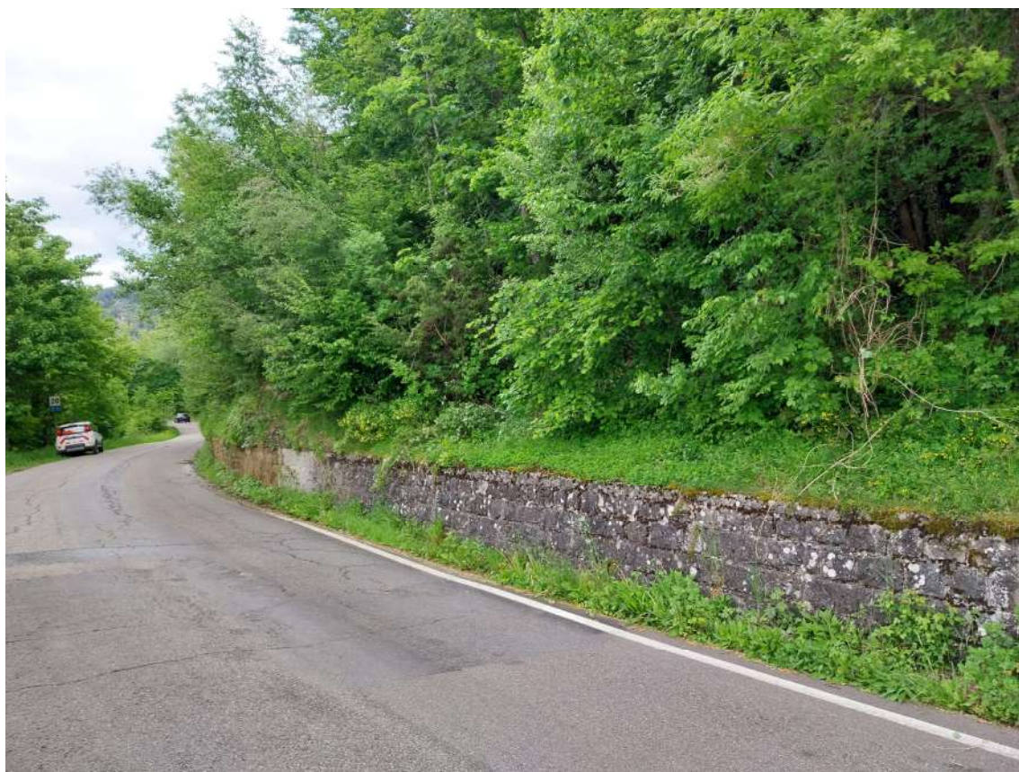
Foto 2 e 3- Vista del muro di sasso a sostegno della scarpata monte Tratto B
