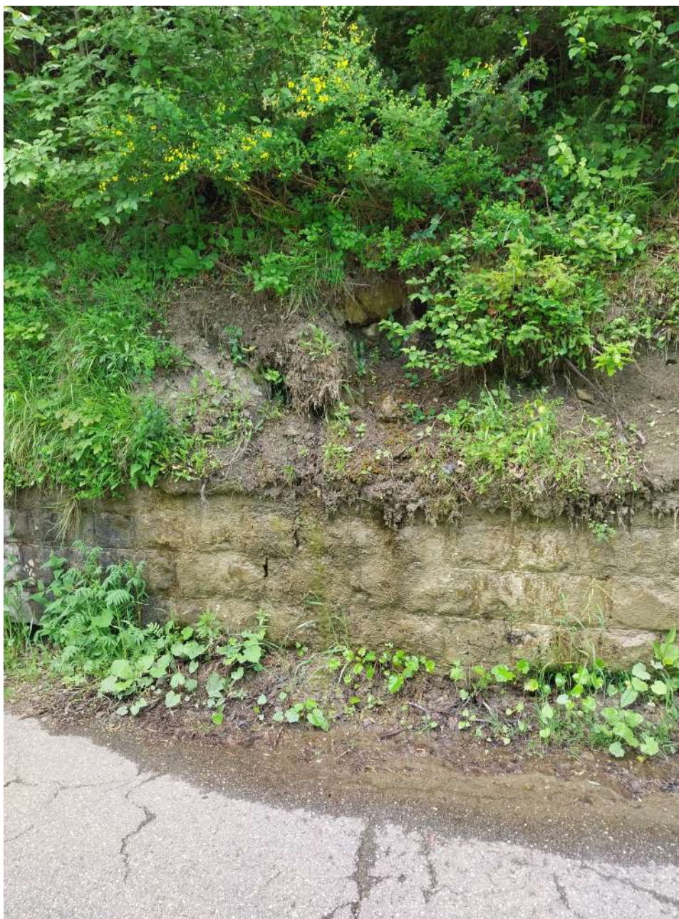
Foto 6- Vista del muro di sasso deteriorato dal dilavamento delle acque superficiali provenienti dalla scarpata di monte
