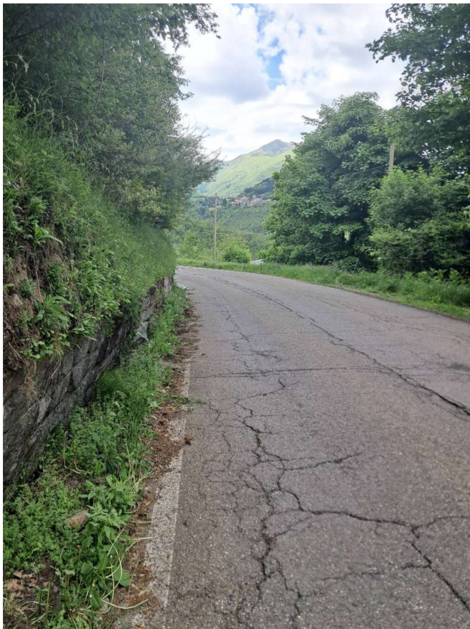
Foto 4- Particolare del muro di sostegno in sasso spanciato verso la carreggiata stradale
