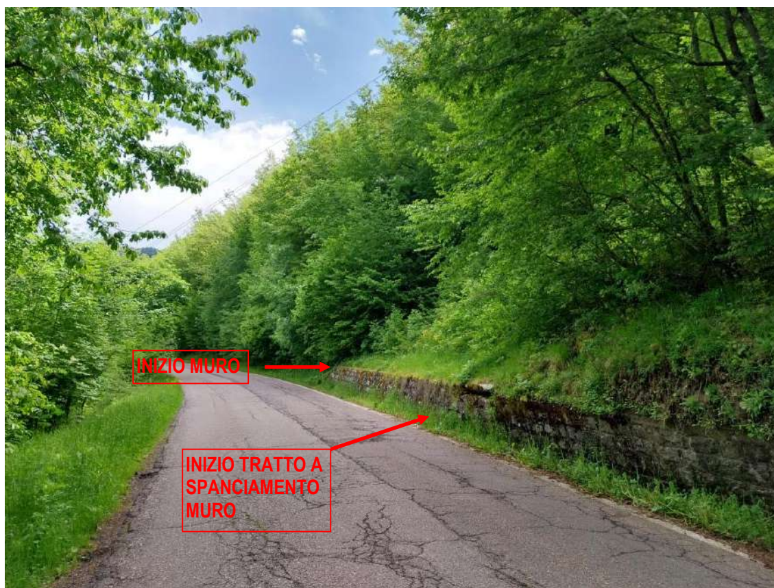
Foto 1- Vista del muro di sasso a sostegno della scarpata monte spanciato e Inizio del TRATTO A
