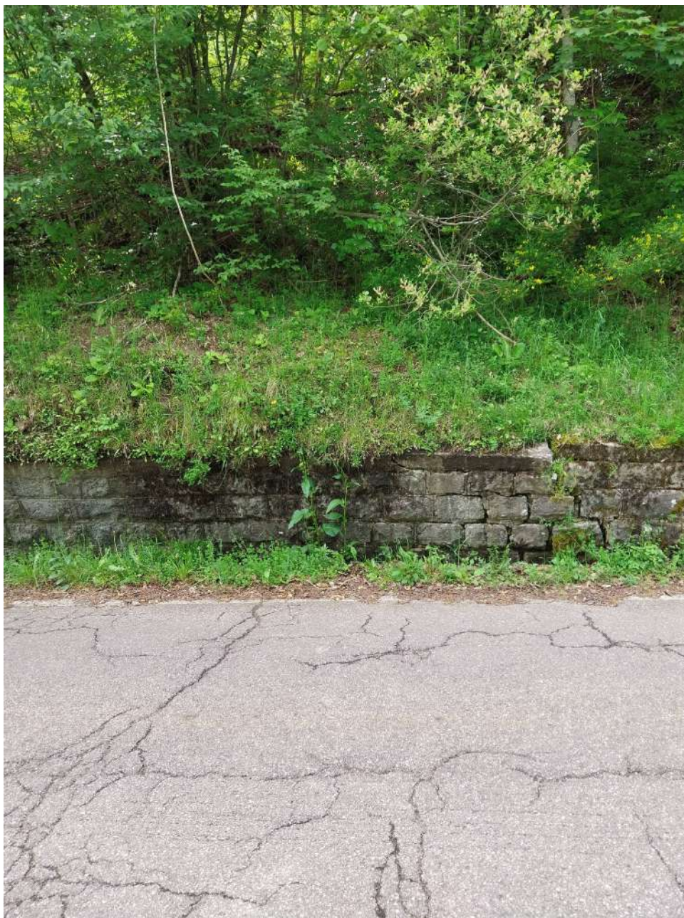
Foto 5- Vista del muro di sasso deteriorato
