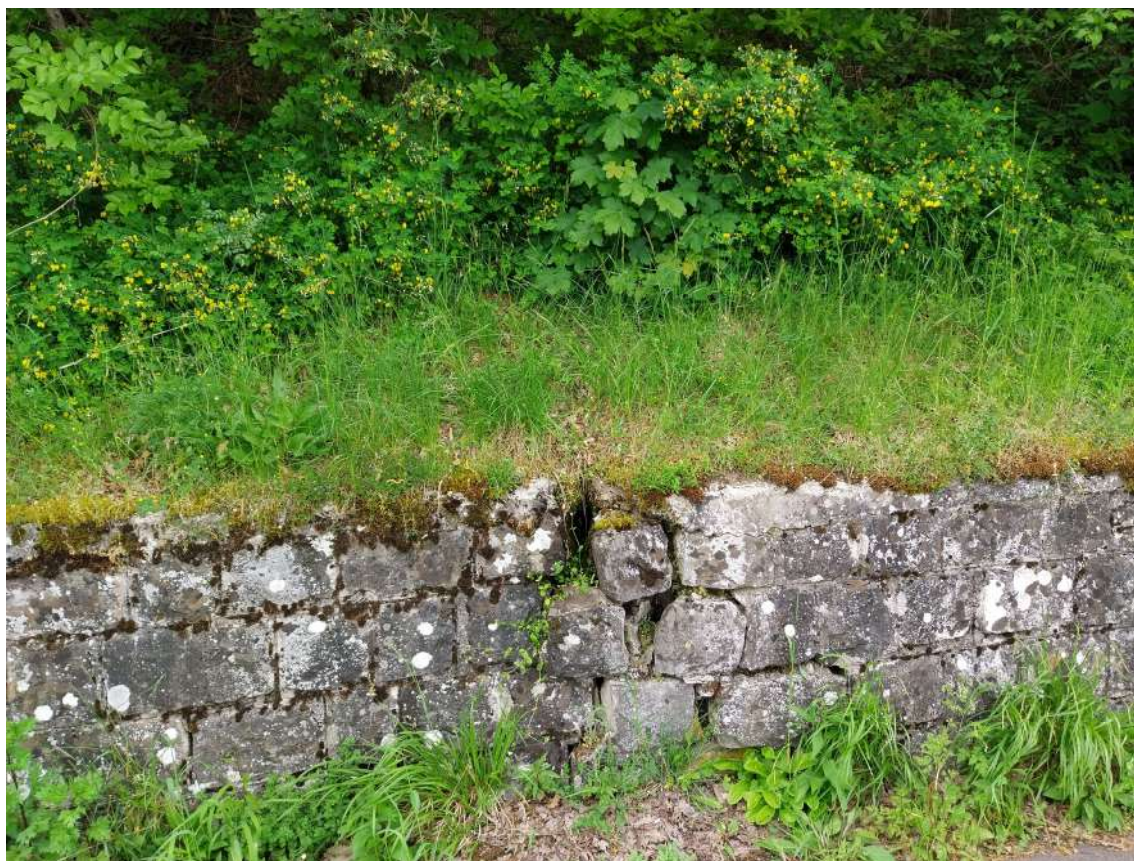
Foto 7- Distacco dei conci in pietra del muro di sostegno esistente
