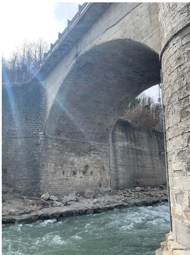
Settimo arco, dove si concentra la quasi totalità della portata del Torrente Dolo
