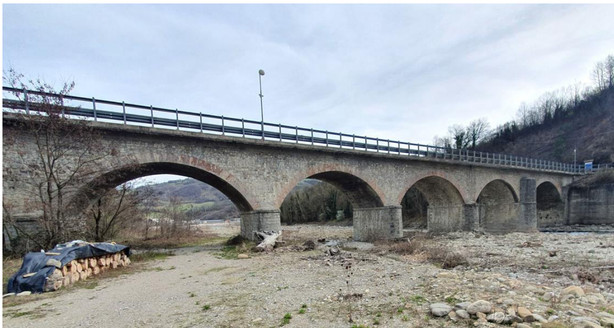
Vista del ponte lato di monte (prospetto Ovest)
