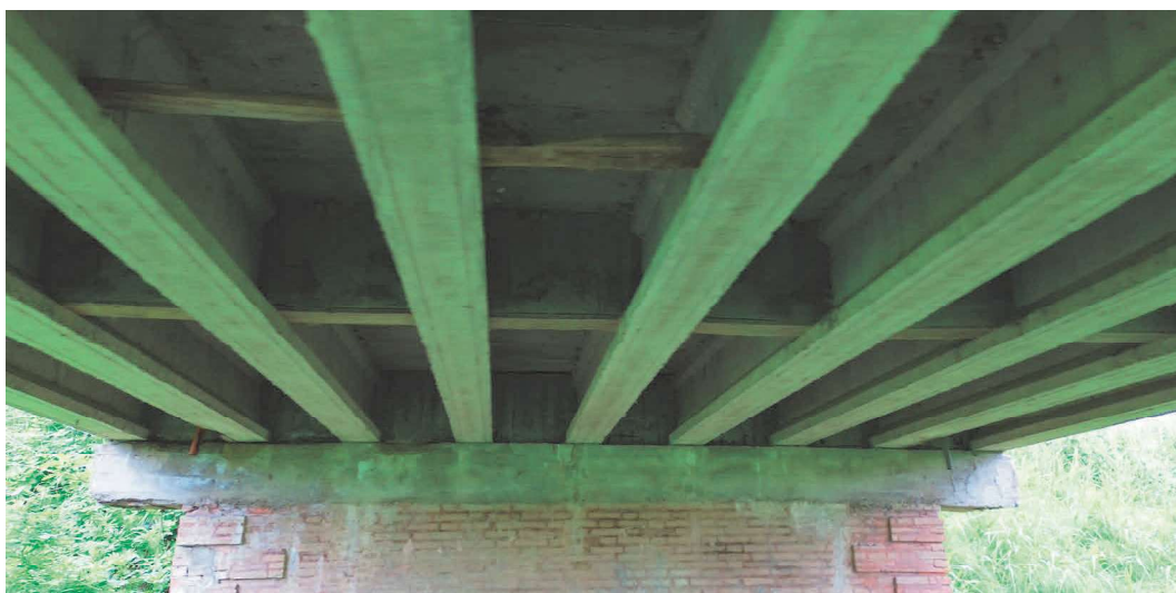
Figura 14 – Ponte sul Cavo Cava (intradosso impalcato lato est)
