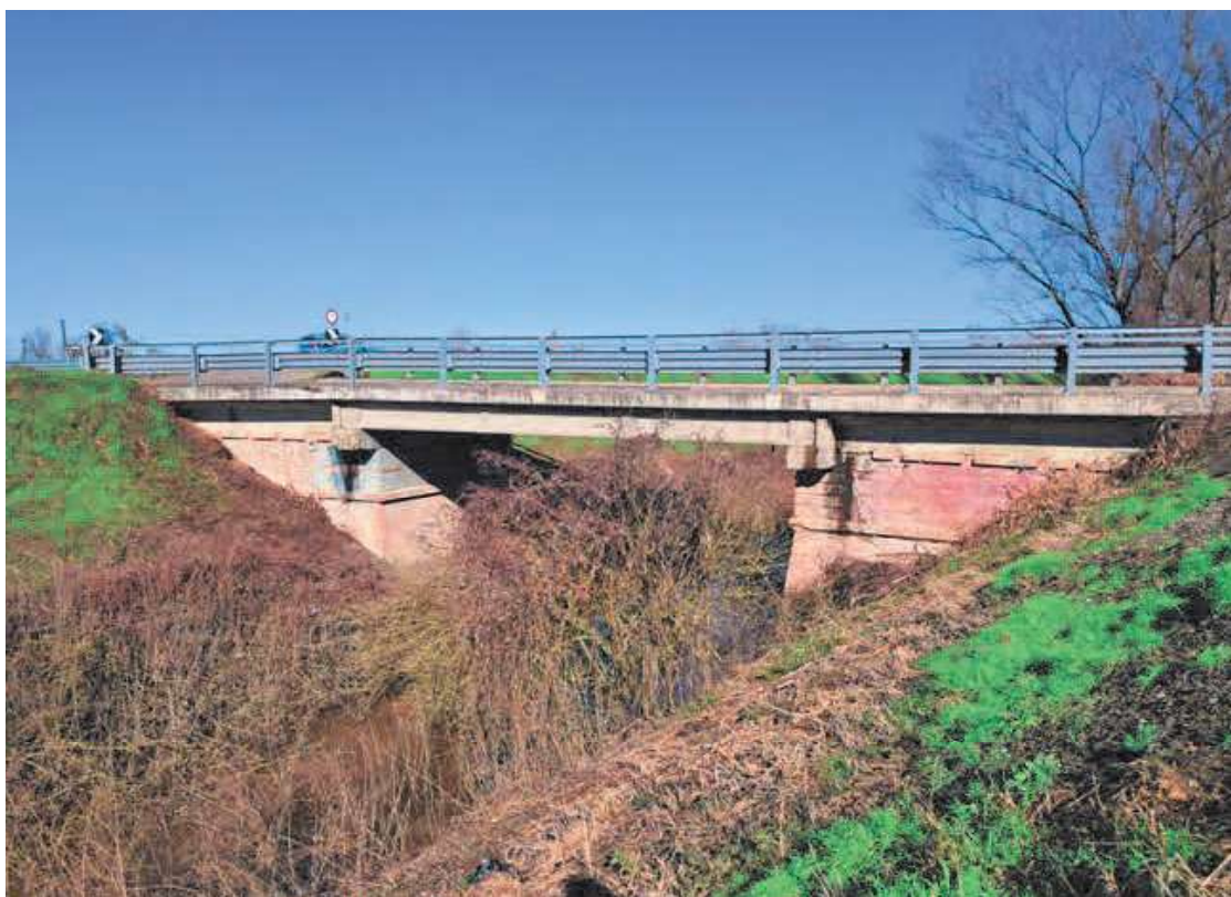
Figura 11 – Ponte sul Cavo Cava (vista da monte)
