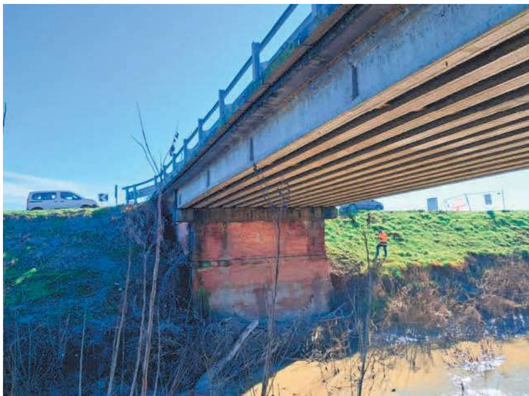
Figura 10 – Ponte sul Crostolo (vista da valle)
