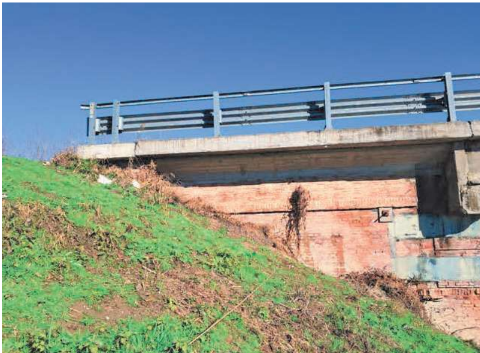
Figura 9 – Ponte sul Crostolo (spalla sponda idraulica di sinistra)
