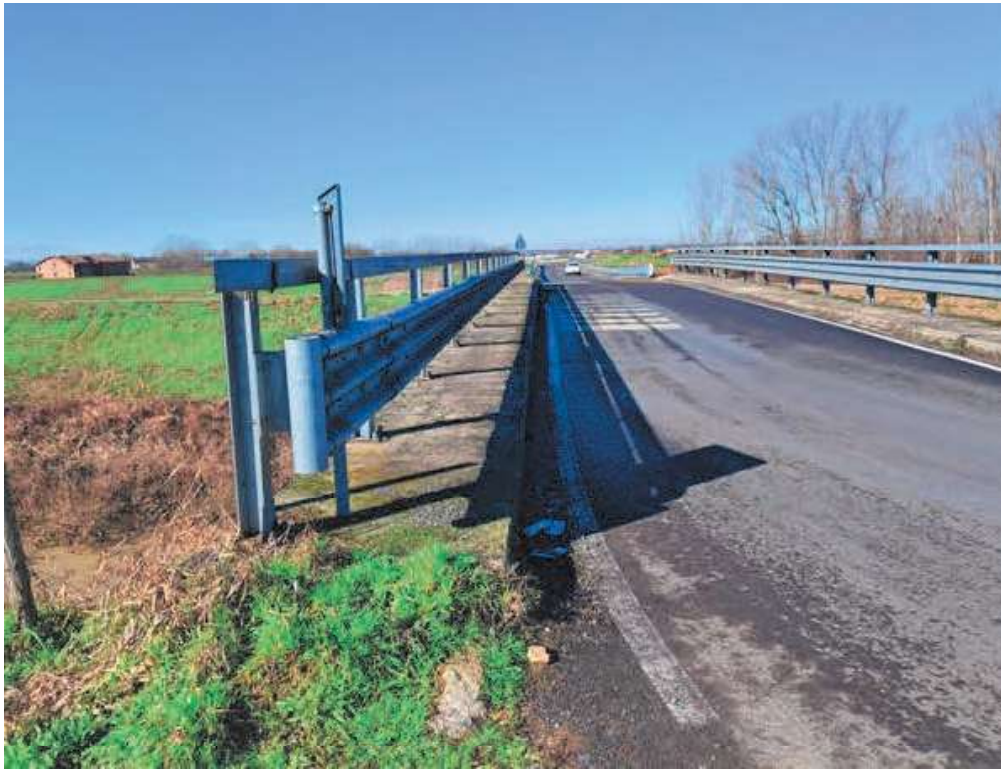
Figura 7 – Ponte sul Crostolo (pavimentazione stradale, vista da est)
