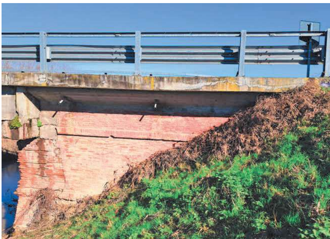
Figura 6 – Ponte sul Crostolo (muri andatori spalla sponda idraulica di destra)
