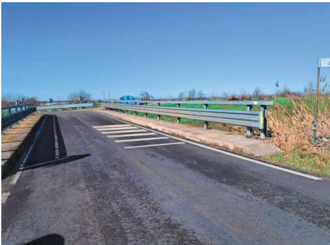
Figura 13 – Ponte sul Cavo Cava (pavimentazione stradale vista da est)
