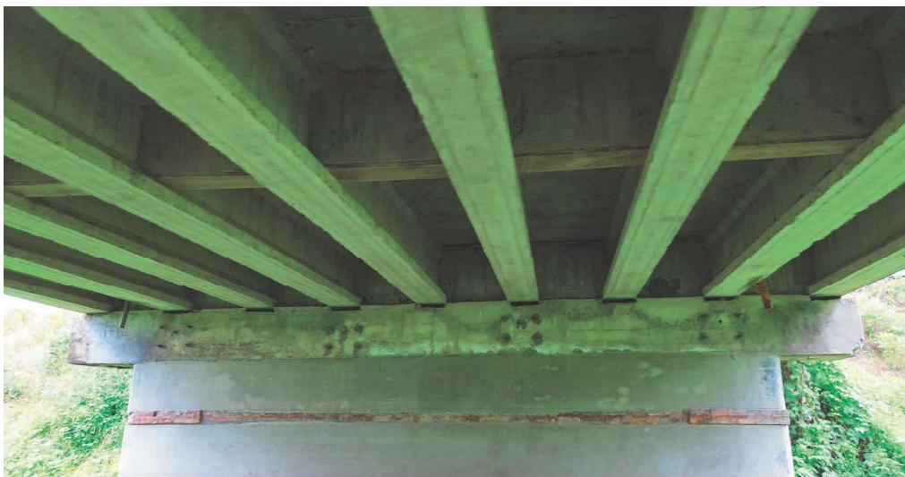
Figura 15 – Ponte sul Cavo Cava (intradosso impalcato lato ovest)
