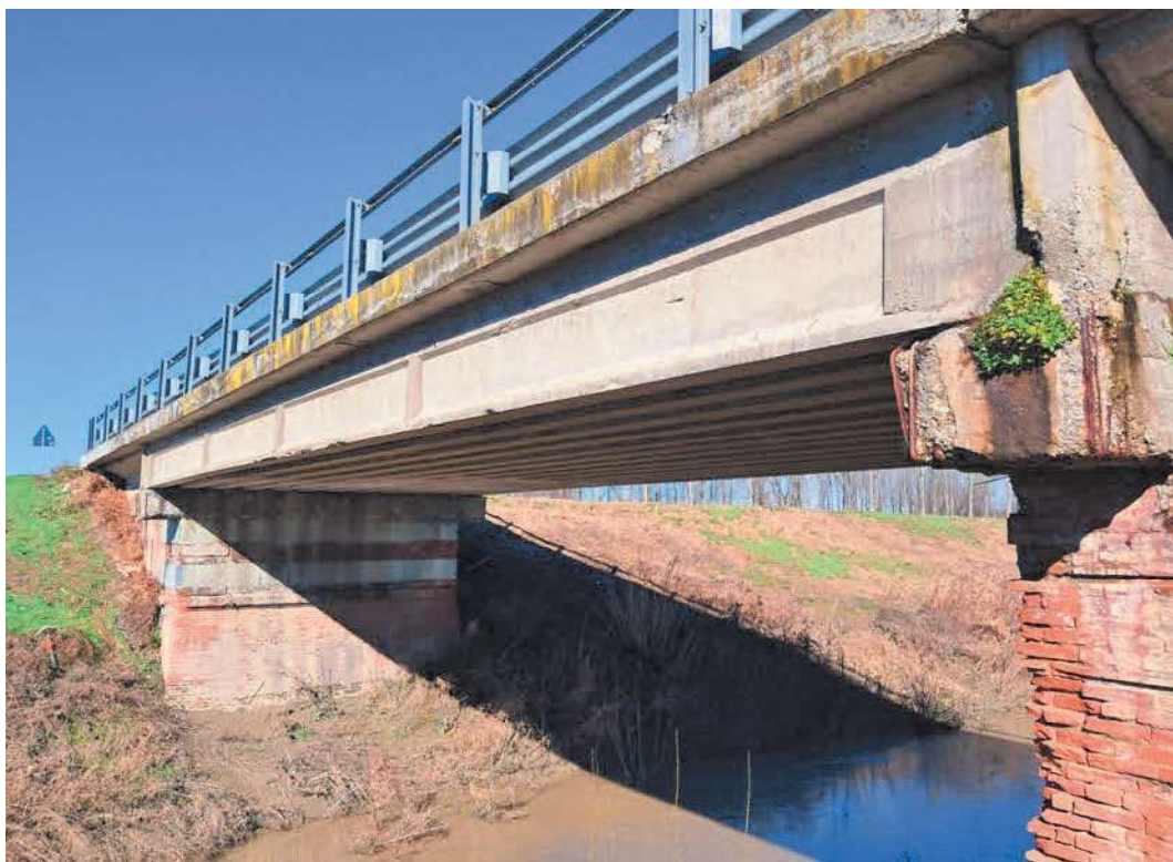
Figura 3 – Ponte sul Crostolo (vista da monte)
