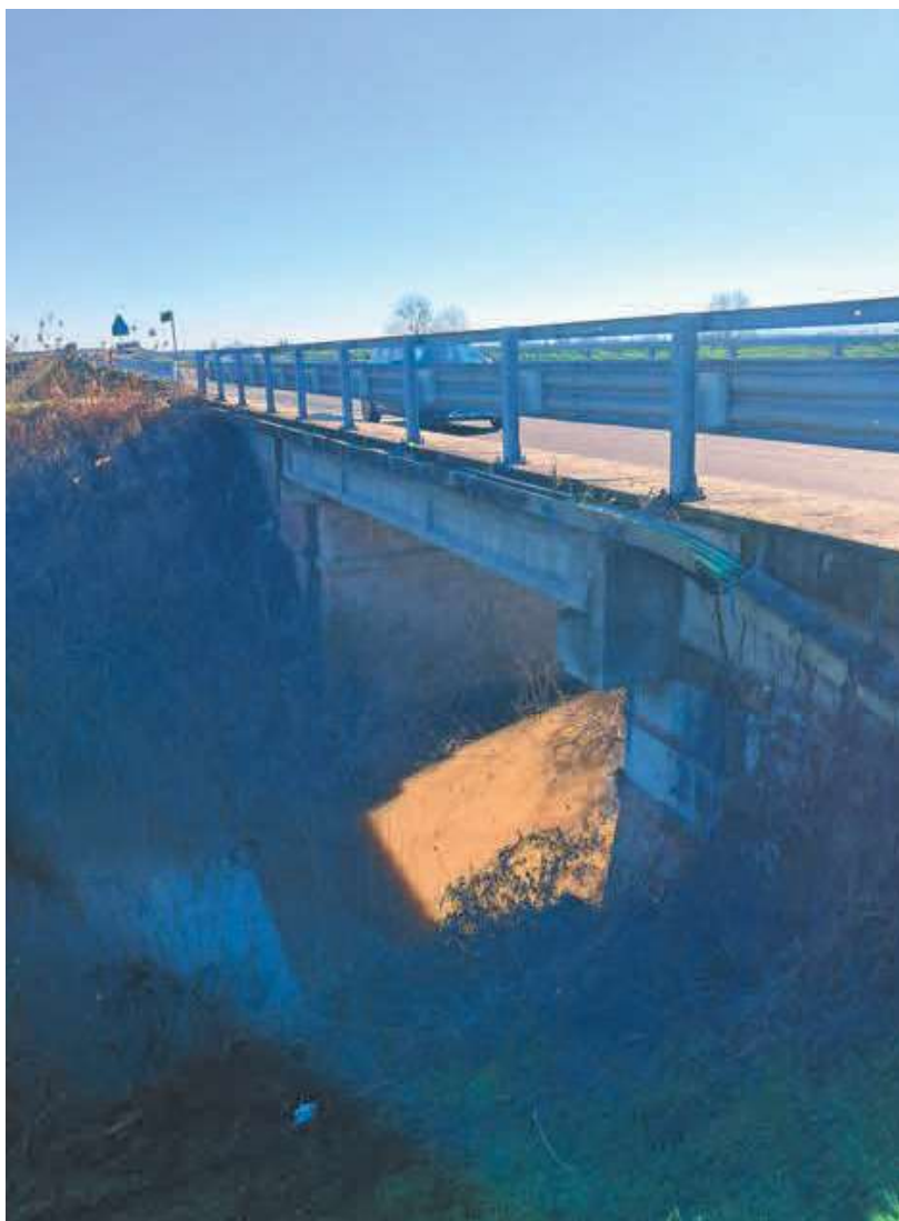
Figura 12 – Ponte sul Cavo Cava (vista da valle)
