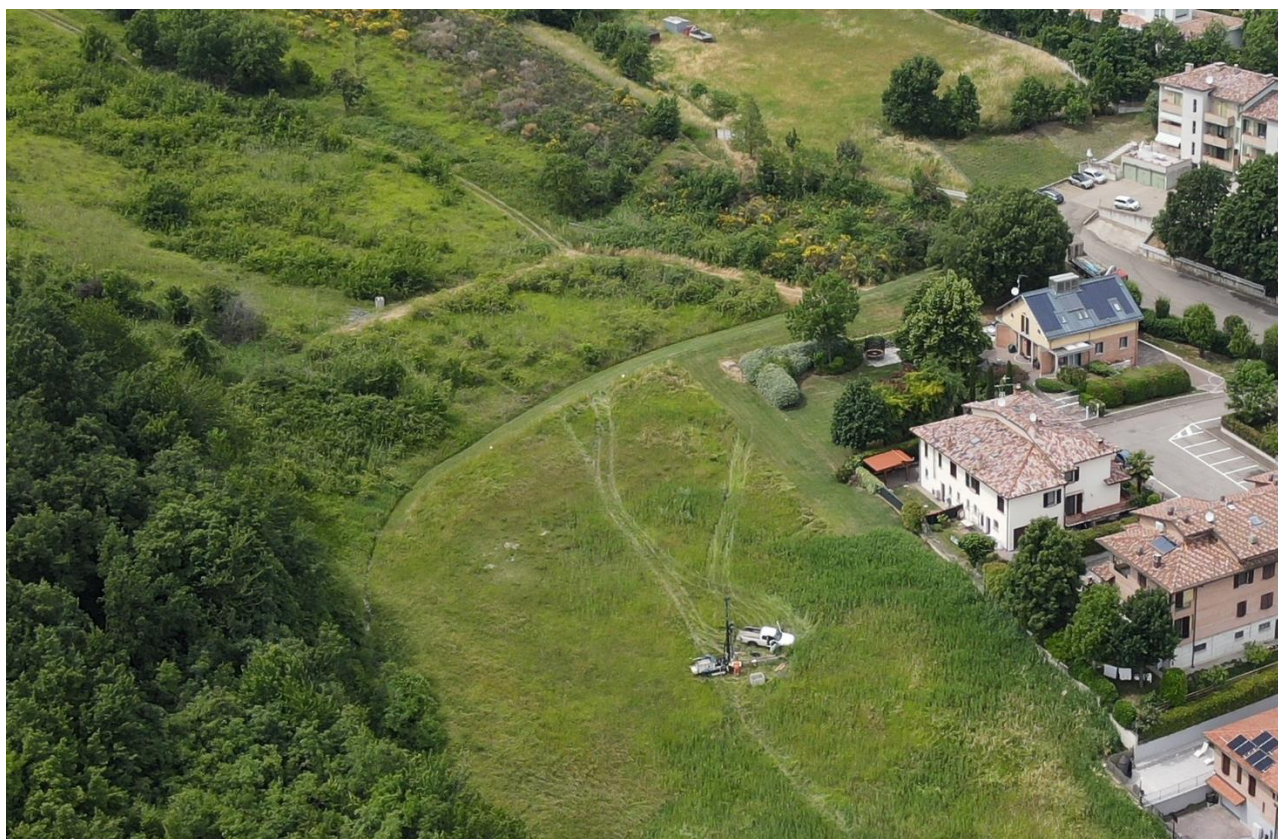
[Figura n. 30 – Ripresa fotografica del gradone in terra compattata]
