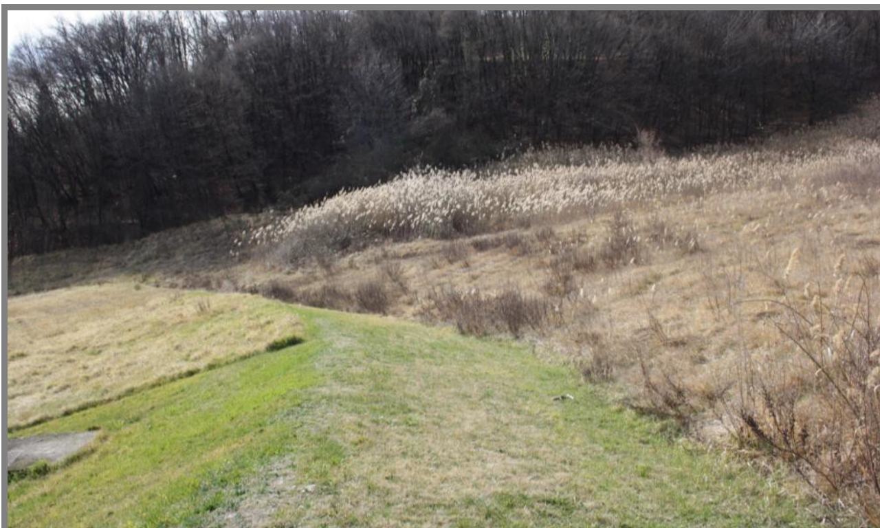
Fig. 5.6 - Terrapieno realizzato per il contenimento e la deviazione delle acque di deflusso, nella parte terminale della frana (Foto M. Soldati) (da "Studi ed indagini geo-ambientali del territorio del Comune di Castellarano (RE) Relazione finale" a cura di Paola Coratza, Alessandro Ghinai, Carlotta Parenti e Mauro Soldati - Dipartimento di Scienze Chimiche e Geologiche dell'Università degli Studi di Modena e Reggio Emilia)
