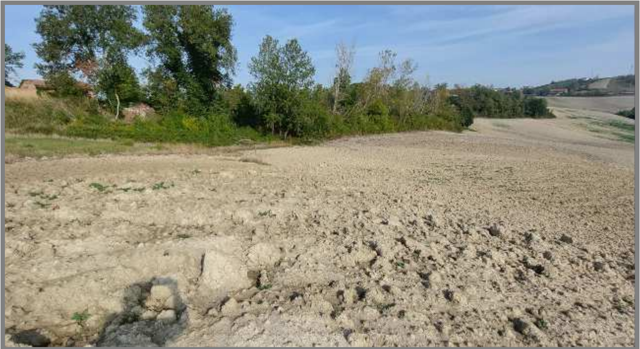
Fig. 2.2 - Area n. 4.3: veduta dall'alto - fianco sinistro della frana (Foto M. Pizziolo)
