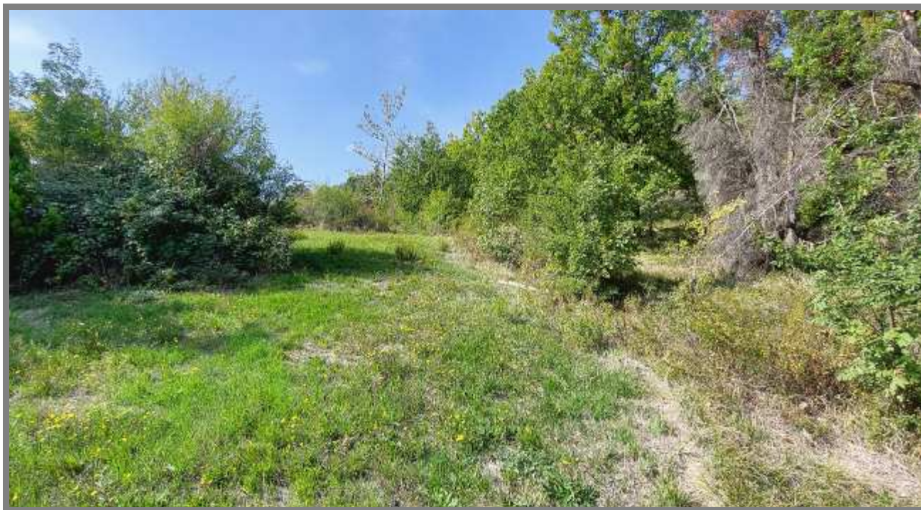
Fig. 6.1 - Area n. 4.2: Stato attuale del corpo di frana senza evidenze di movimento - cartografia in Fig. 5.2 (Foto M. Pizziolo)
