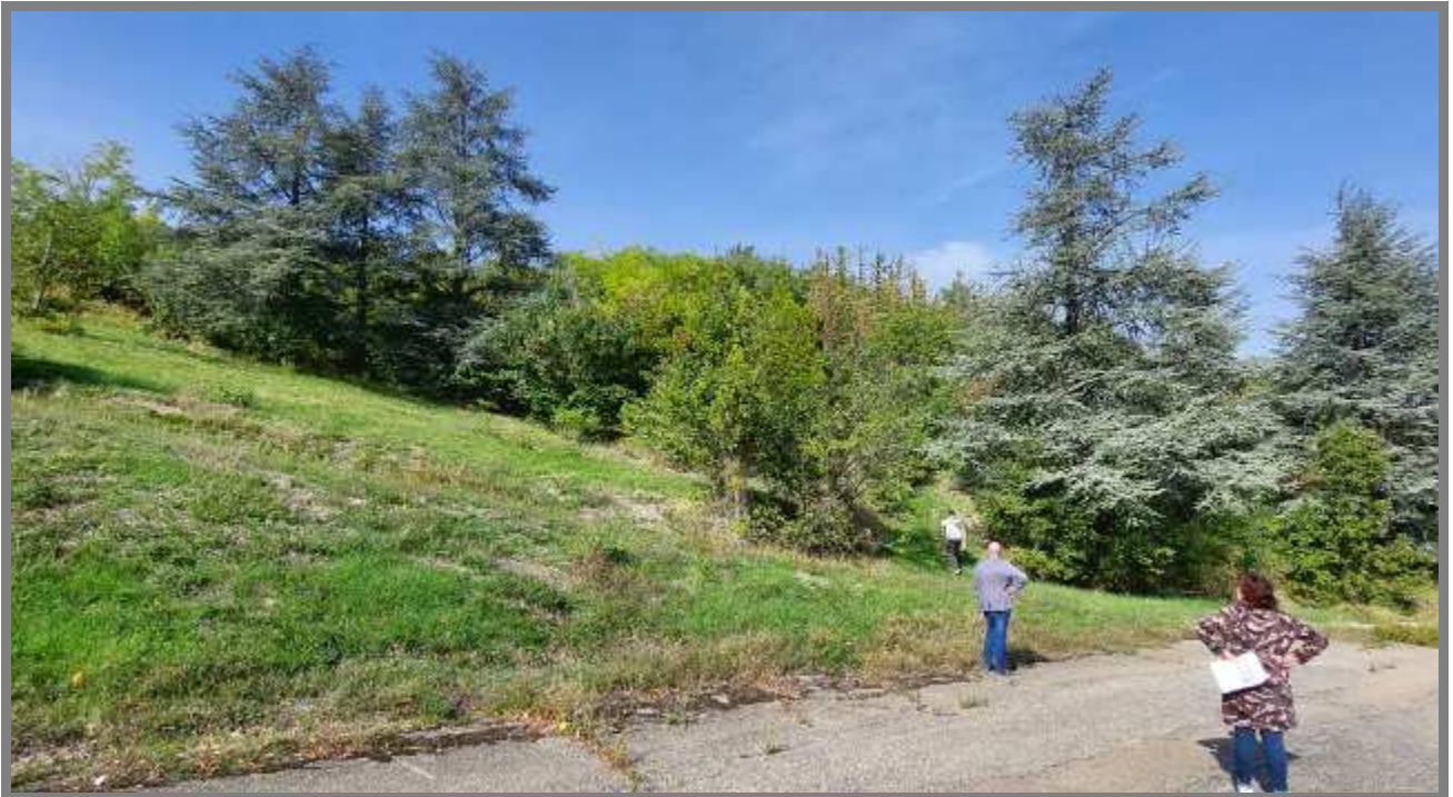
Fig. 6.2 - Area n. 4.2: Parte basale del corpo di frana - cartografia in Fig. 5.2. (Foto M. Pizzolo)
