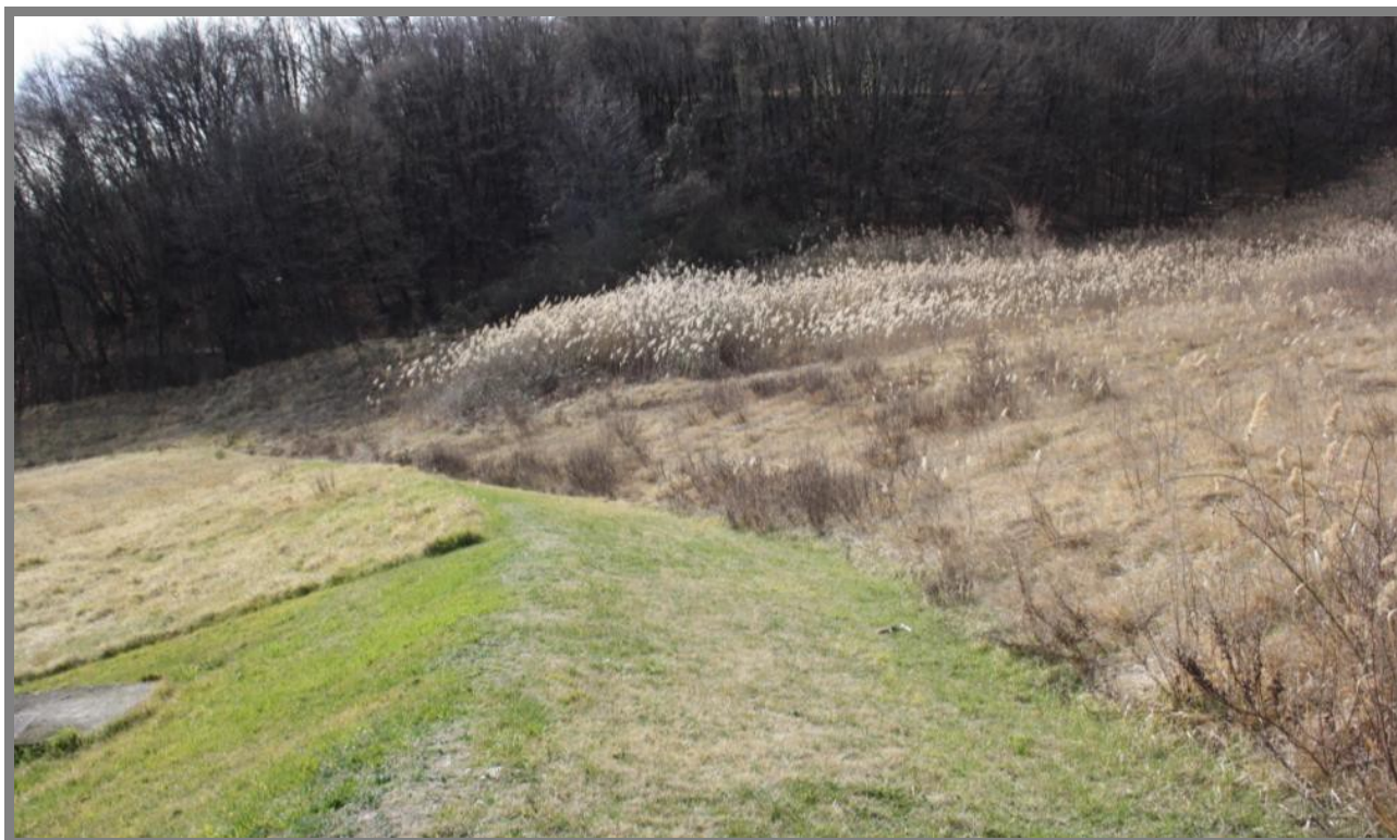
Fig. 2 - Terrapieno realizzato per il contenimento e la deviazione delle acque di deflusso, nella parte terminale della frana (Foto M. Soldati) (da "Studi ed indagini geo-ambientali del territorio del Comune di Castellarano (RE) Relazione finale" a cura di Paola Coratza, Alessandro Ghinoi, Carlotta Parenti e Mauro Soldati - Dipartimento di Scienze Chimiche e Geologiche dell'Università degli Studi di Modena e Reggio Emilia)
