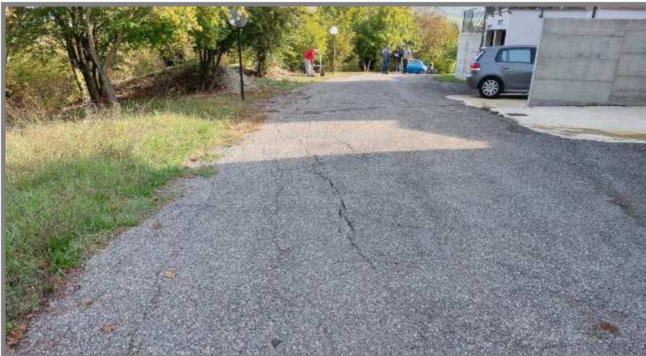
Fig. 3.3 - Area n. 4.4: lesioni sulla strada di accesso alla parte bassa del nucleo abitato (Foto M. Pizziolo)
